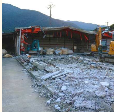
▲重機による解体
